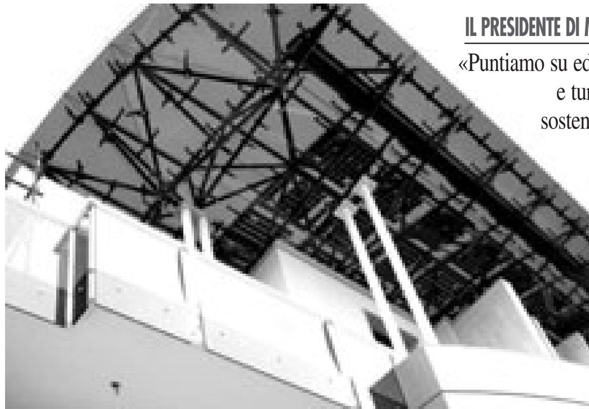
La residenza I Cristalli, costruzione di classe A, realizzata a Latina dall'impresa di Renato e Paolo Neroni
